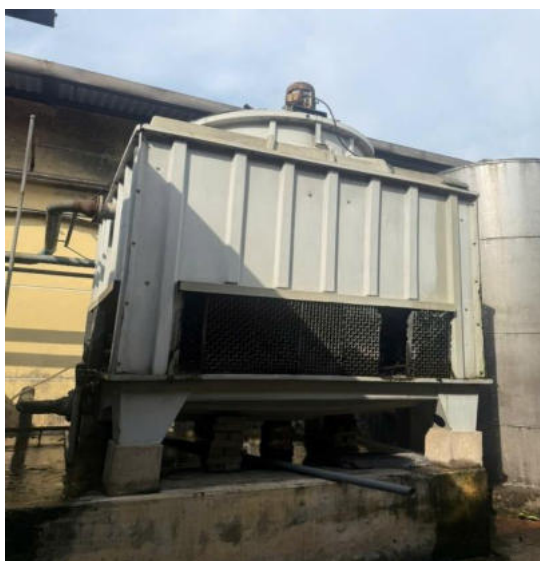
Hình 14. Tháp giải nhiệt của Công ty
