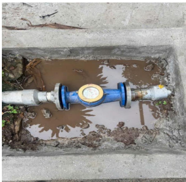
Hình 7. Đồng hồ đo lưu lượng xả nước thải
